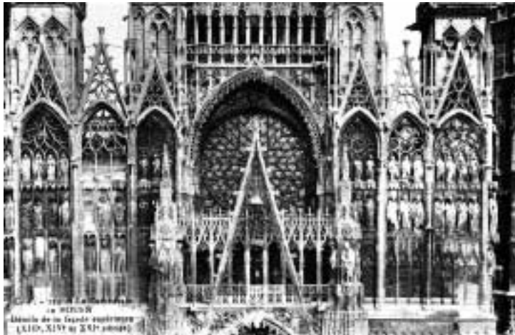
Abb. 2 - Westwerk der Kathedrale von Rouen
